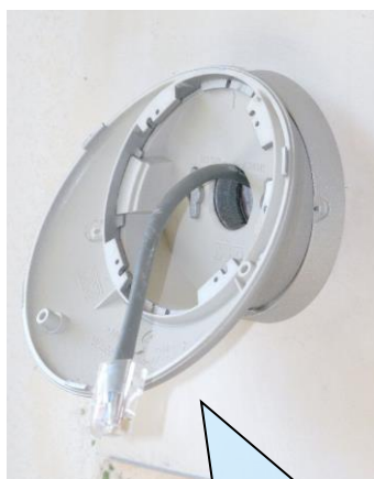
2. zadní díl krabice se na montážní držák nasune
