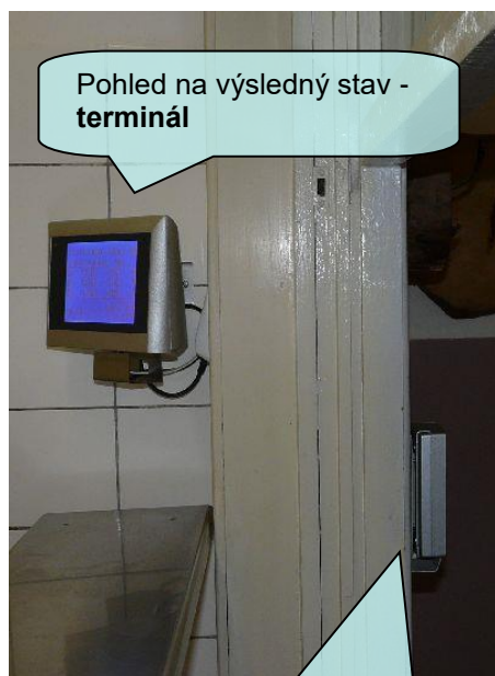
... čtecí jednotka . Délka kabelu mezi čtecí jednotkou a terminálem nesmí být delší než 3m.
