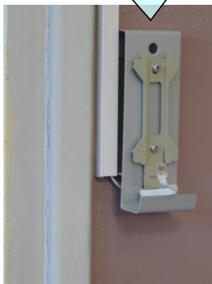
Příprava montážního držáku a propojovacího kabelu pro čtecí jednotku.
