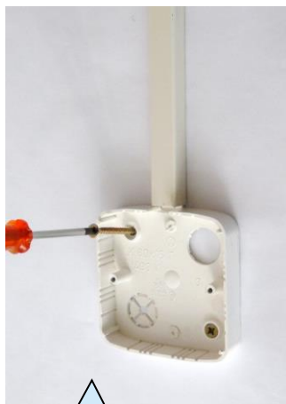
Montáž krabice LK80 na omítku
