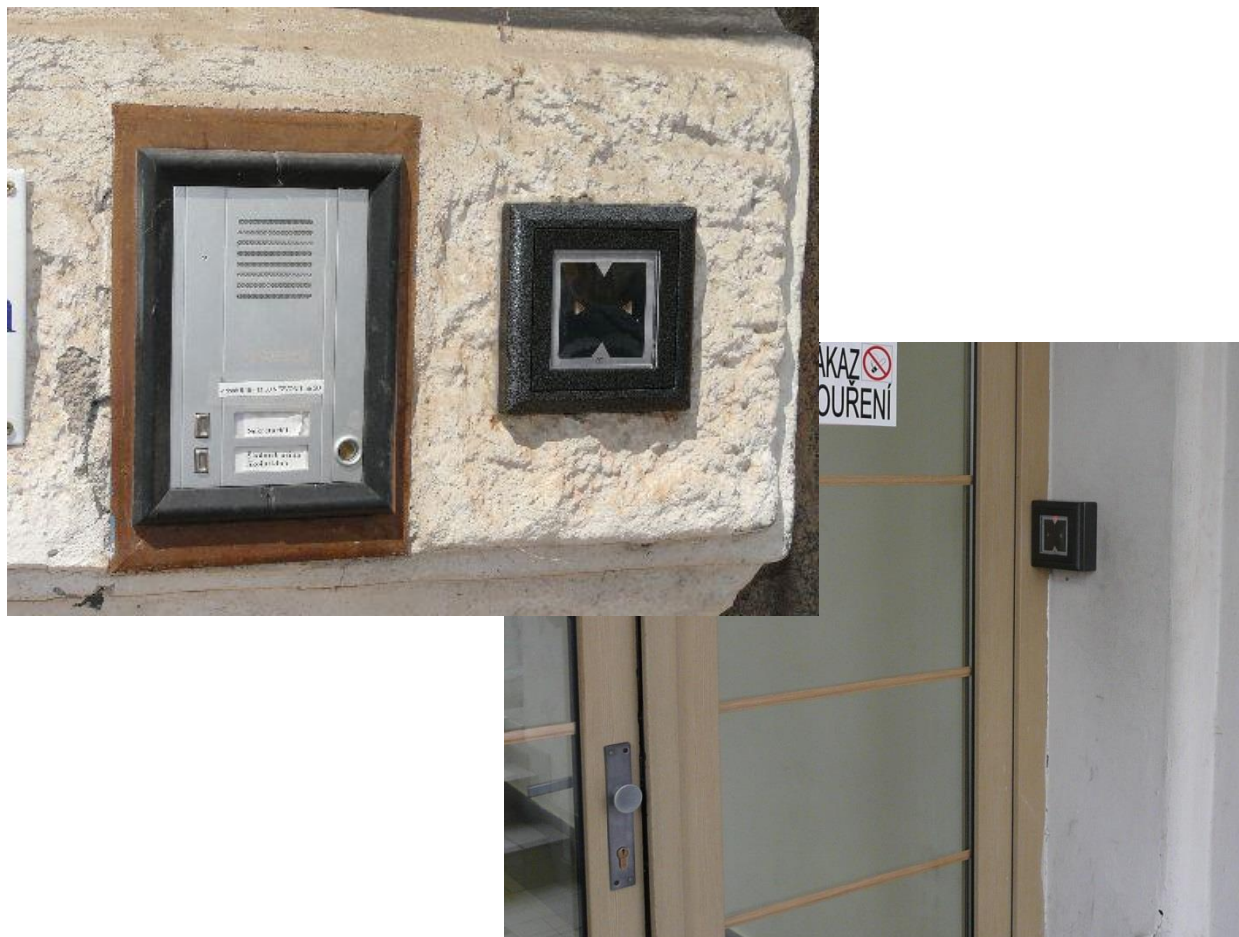
Příklady instalace terminálu v krabici Antivandal
